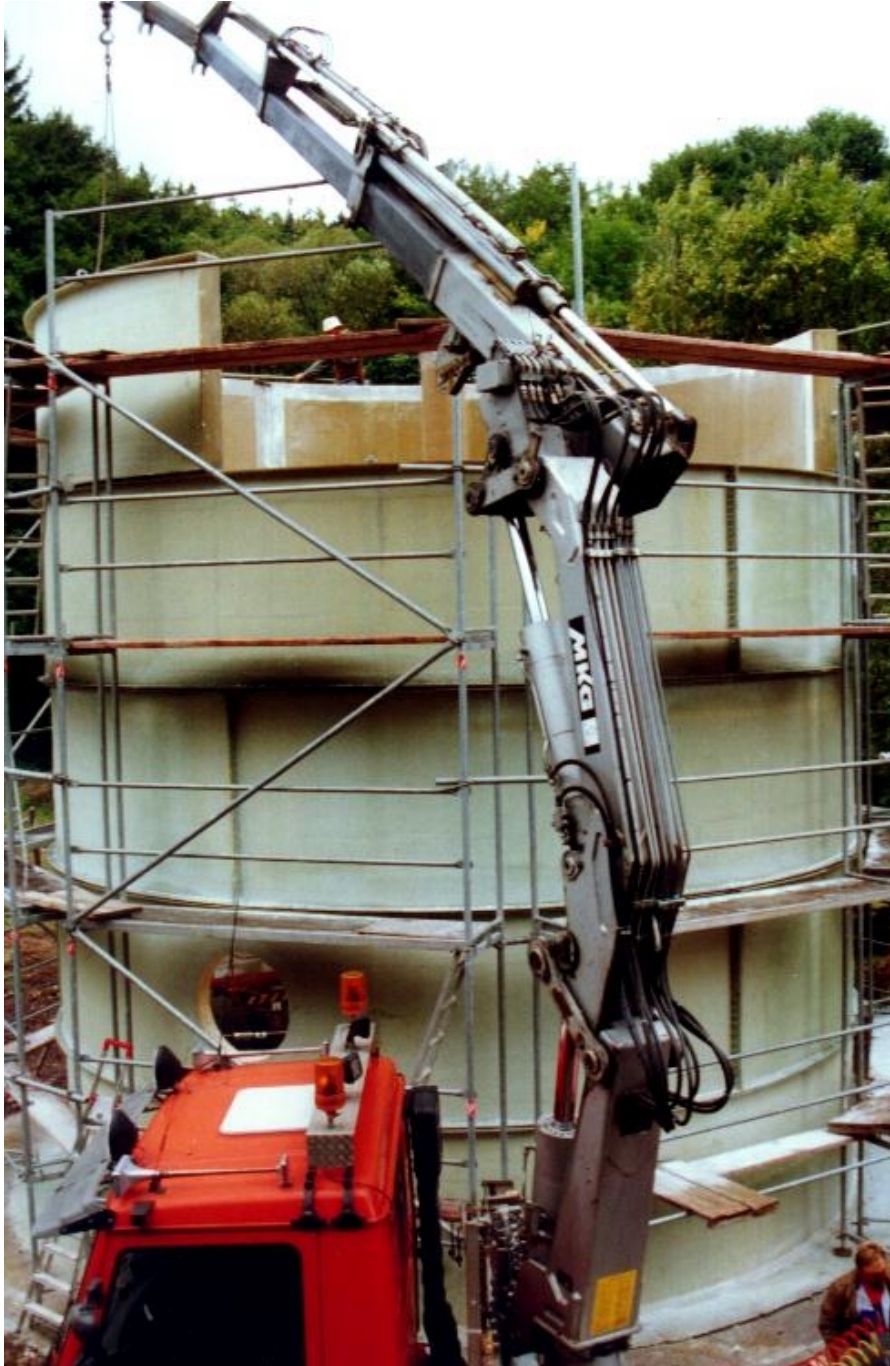
Abbildung 11: 300 m 3 GFK-Heißwasser-Speicher (Prototyp) bei der Montage [15], Entwicklung der TU Ilmenau, Arbeitsgruppe regenerative Energien und Umweltmeßtechnik
