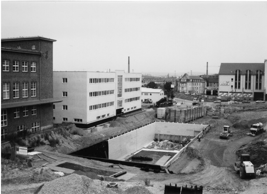
Abbildung 13: 8000 m 3 Kies-Wasser-Speicher, solar unterstütztes Nahwärmesystem im Chemnitzer solarisPark, Baugrube mit isolierten Seitenwänden, Einbau der Dichtschicht (PE-HD-Folie), [1], [2], [5], [6], [7]
