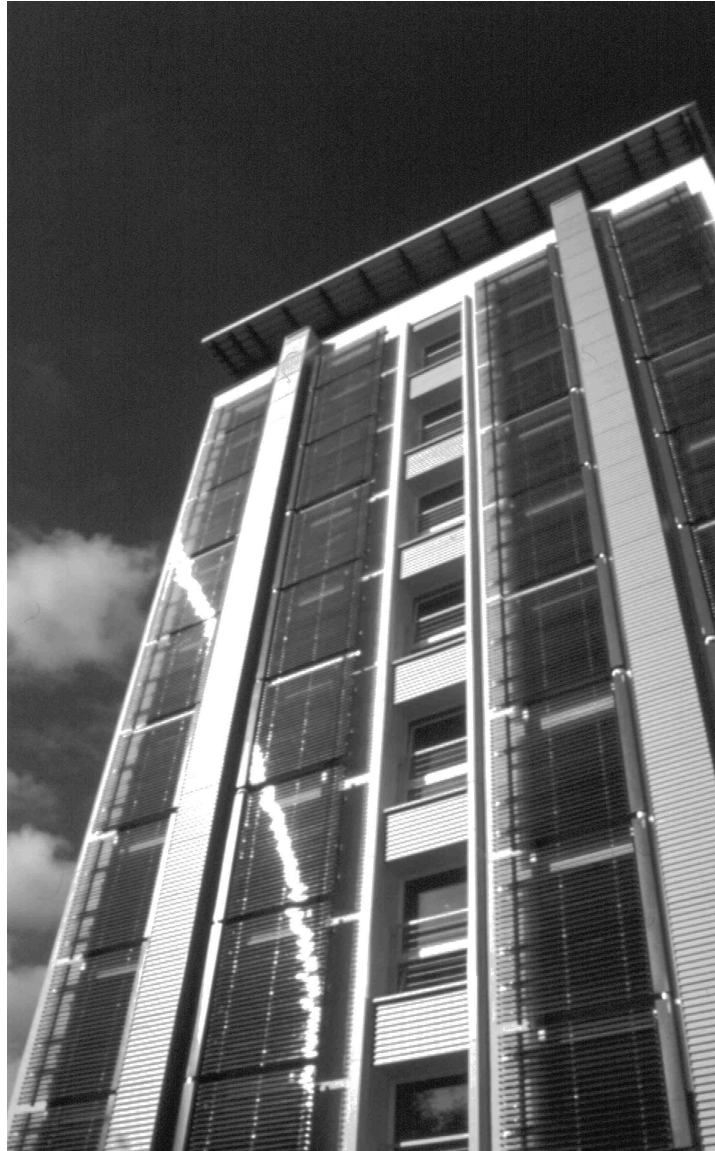
Abbildung 10: Fassadenintegration von Vakuum-Röhrenkollektoren, solar unterstützte Brauchwassererwärmung Studentenwohnheim in Chemnitz, 100 m 2 Kollektorfläche, 7000 l Kurzzeit-Speicher (Stahltank), sehr gutes Beispiel für die Nutzung der Kollektoren als gestalterisches Element, wegen mangelhafter Abstimmung im Vorfeld aus energetischer Sicht nicht optimal am Baukörper platziert
