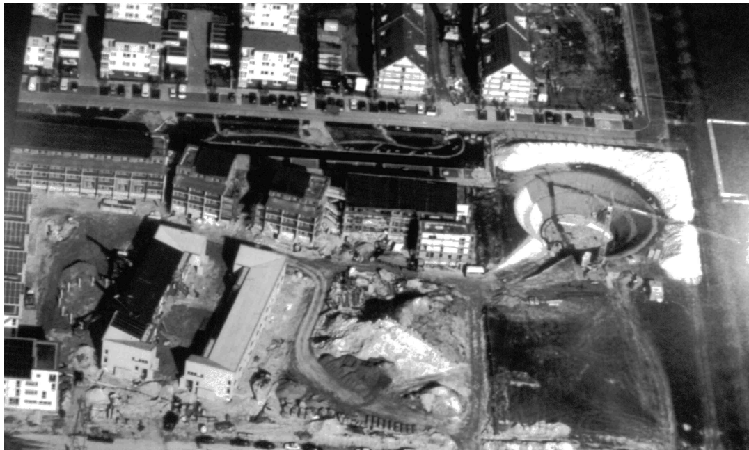
Abbildung 12: 2750 m 3 Heißwasser-Speicher, solarunterstütztes Nahwärmesystem Hannover-Kronsberg, 1350 m 2 Kollektorfläche, ca. 106 Wohneinheiten, Foto: Michael Bodemann
