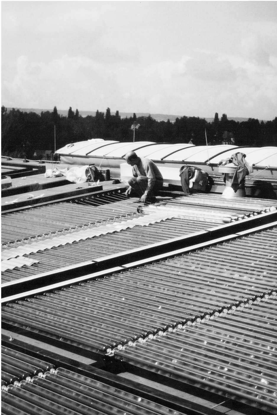
Abbildung 9: Montage von auf der Dachfläche aufgelegten Vakuum-Röhrenkollektoren, kostenminimale Unterkonstruktion aus Brettschichtholz, solar unterstütztes Nahwärmesystem solarisPark [1], [2], [6], [7], [8]
