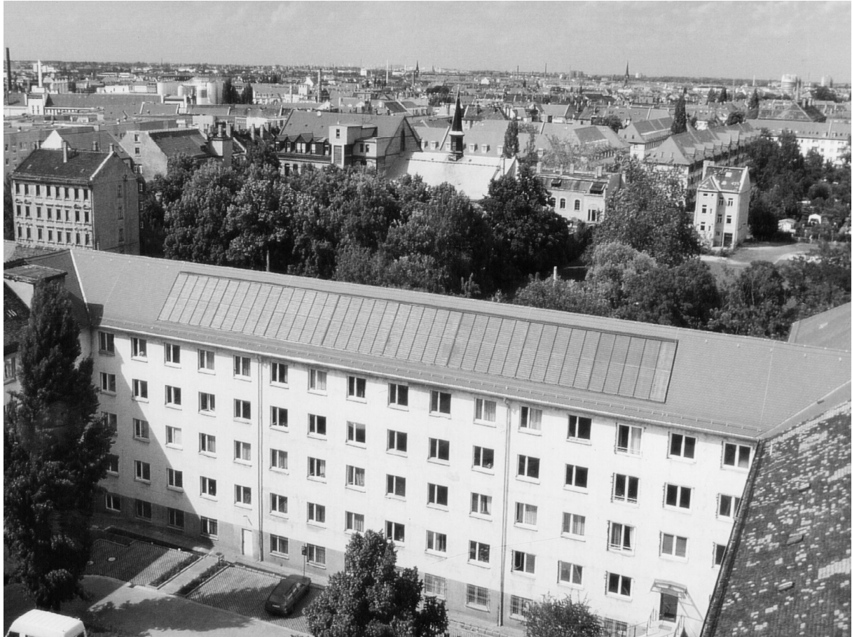
Abbildung 6: Dachintegrierte Kollektoren solar unterstützte Brauchwassererwärmung, Städtisches Altenpflegeheim „M. A. Nexö“ in Leipzig, 294 m 2 Kollektorfläche, 14000 l Kurzzeit-Speicher (Stahltank), Foto: Thomas Freitag
