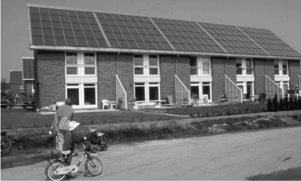
Abbildung 7: Solardach (solar roof), solares Nahwärmesystem Hamburg-Bramfeld, 3000 m 2 Kollektorfläche, 4500 m 3 Heißwasser-Speicher, ca. 123 Wohnungseinheiten
