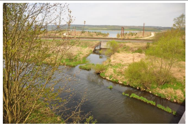
Durch diesen Kanal wurde der See kontrolliert mit Egerwasser geflutet
