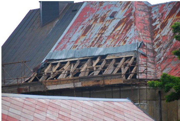
Geöffnetes Dach der Frühbußer Kirche
