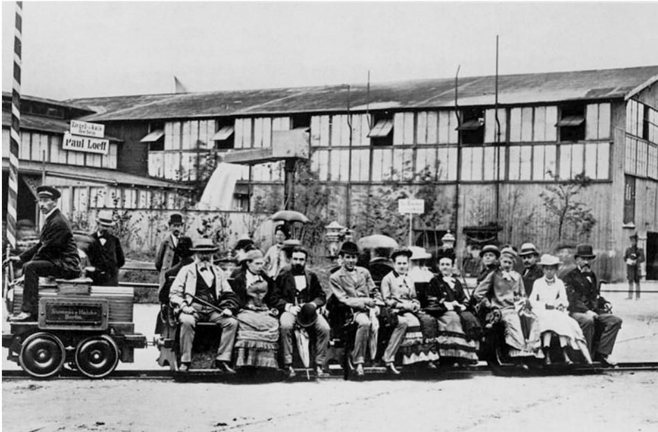
**Abb. 3.8** Erste elektrische Lokomotive auf der Berliner Gewerbeausstellung 1879. (Siemens-Archiv)
