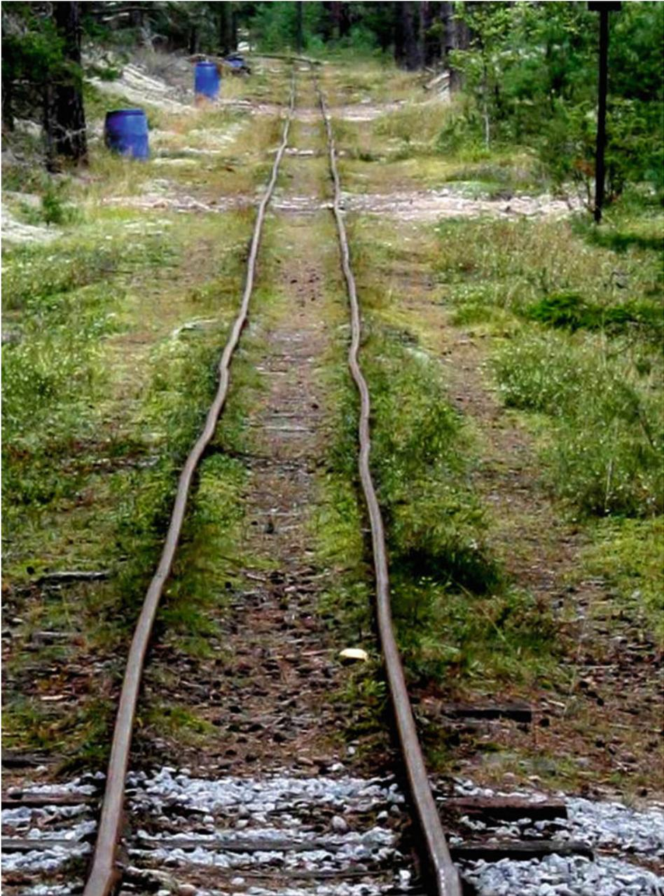
**Abb. 5.1** Zur Verdeutlichung von Gleislagefehlern – Gleis einer schwedischen Waldbahn
