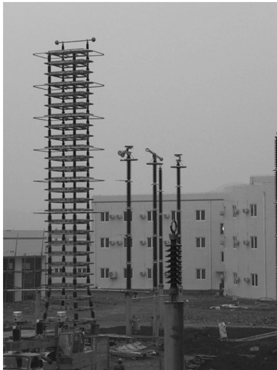
Abb. 3.40 Bau einer Kondensatorbank für eine 750-kV-HGÜ-Anlage (Stenner)
