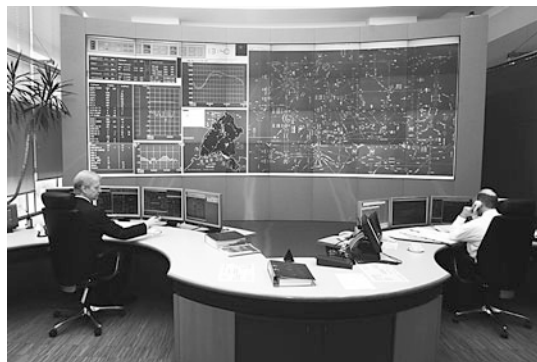
Abb. 8.28 Netzleitwarte der TransnetBW mit LED-Rückwärtsprojektion (TransnetBW GmbH)
