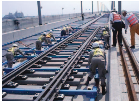
Abb. 5.69 Einbau mittels eines Shifting-Systems (Taiwan)
