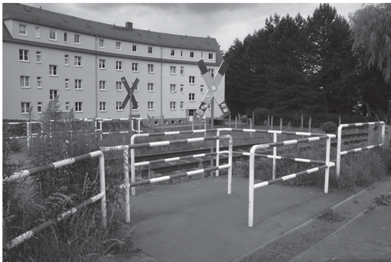
Abb. 13.11 Ausführungsbeispiel einer Umlaufsperrre (bisherige Bauform)
