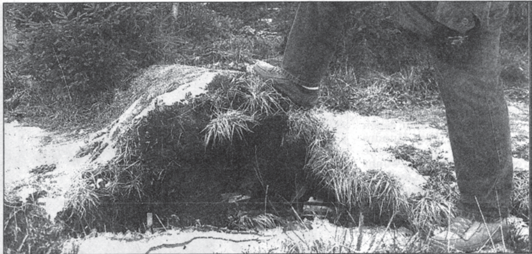
Noch 50 Meter von der Unglücksstelle gibt es Bodenwellen.
