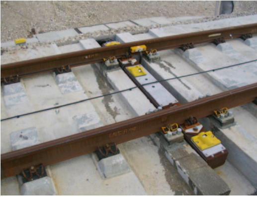
Abb. 15.4 Gleisrüstung einer HOA
