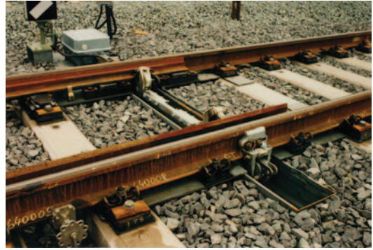
Abb. 5.51 Hohlschwelle mit Verschluss
