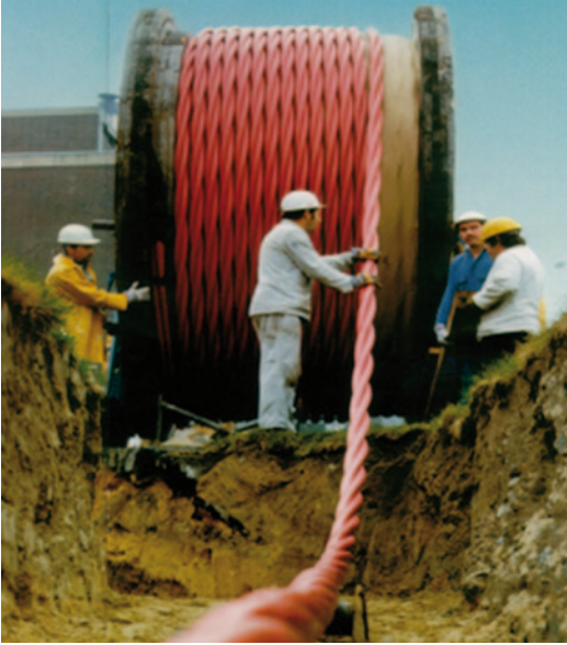
Abb. 16.20 Kabelabzug von der Spule
