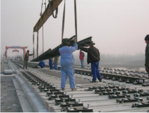
Abb. 5.70 Bögl-Platte mit Schienenstützpunkt
