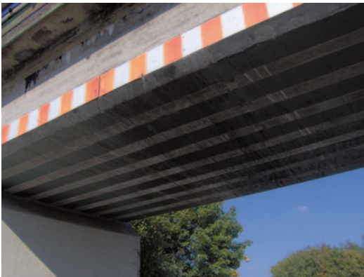
Abb. 7.7 Walzträger in Beton (WIB-Bücke)
