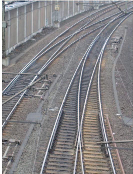
Abb. 5.8 Überhöhte Innenbogenweichen
