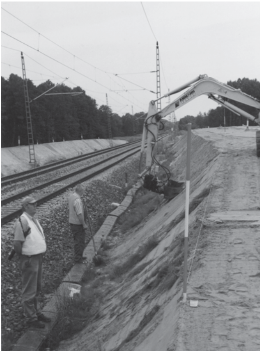
Abb. 4.104 Endprofilierung der Auflastsschüttung. (Moorstelle Dahmetal Februar 2005)
