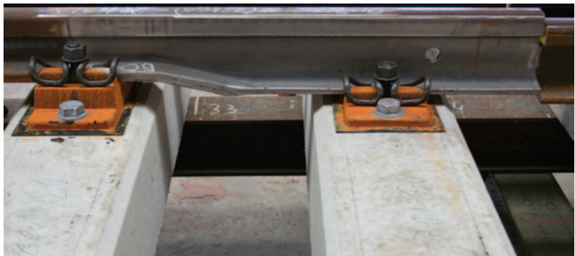
Abb. 5.29 Ausschmiedung des Zungenprofils zum Regelschienenprofil
