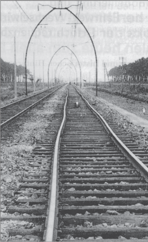
Abb. 2.22 Gleislagefehler
