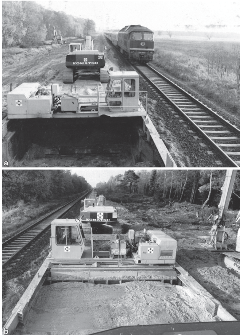
Abb. 4.91 Mooraus- tausch im Bahnkörper mit Vorschubkasten
