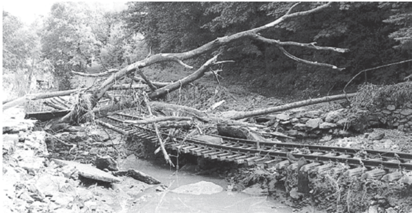
Abb. 4.51 Zerstörungen an Bahnanlagen im Rabenauer Grund. (2002 bei Dresden/Sachsen)
