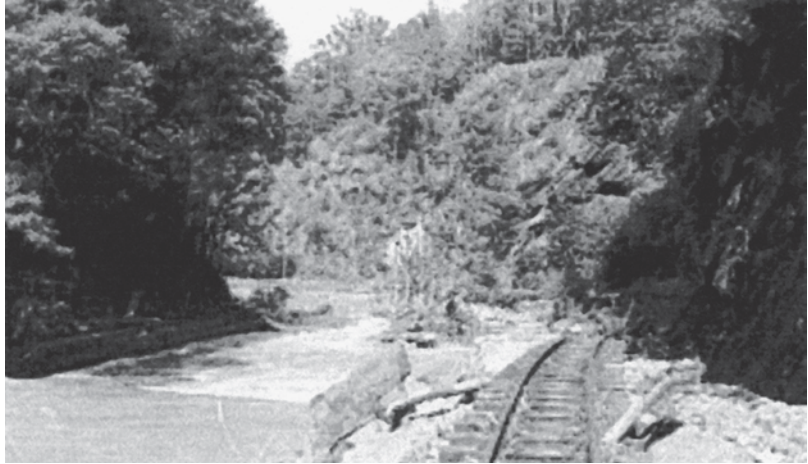
Abb. 4.52 Unterspülungen der Bahnanlagen im Rabenauer Grund. (2002 bei Dresden/Sachsen) (1)
