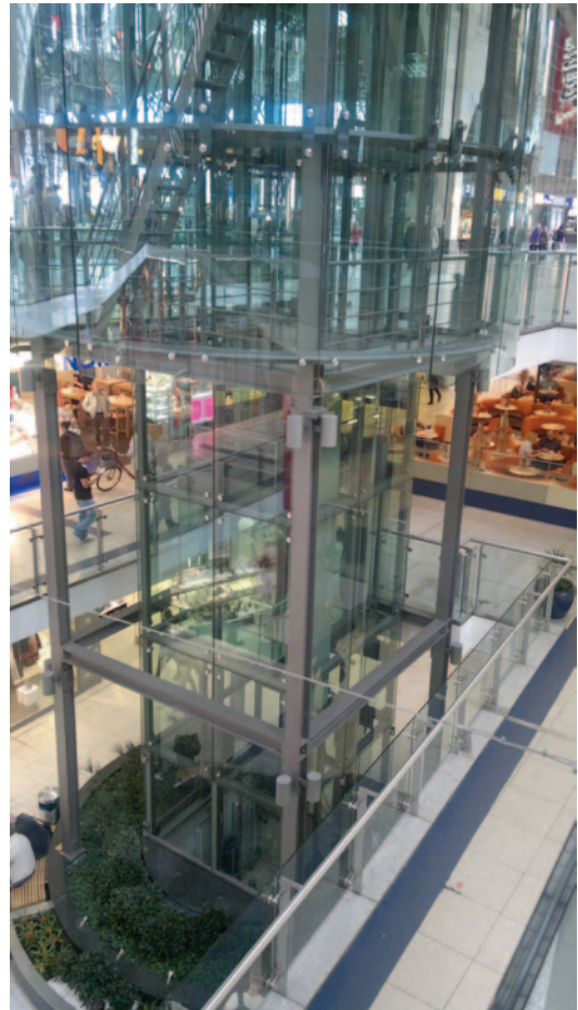
Abb. 15.17 Aufzugsanlage in einem Bahnhof, 3AC 230/400 V 50 Hz, ca. 5 kVA
