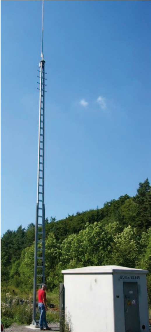
Abb. 17.23 Funkstation des VZF95 mit Mast und Rundstrahler
