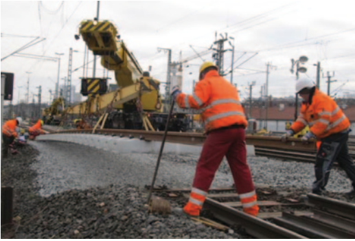
Abb. 5.62 Weichenmontage mit Eisenbahndrehkran
