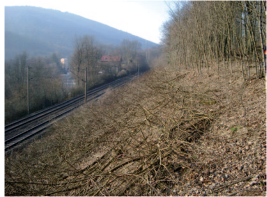
Abb. 19.14 Das Pflegeziel des Leitbildes „Niederwald“ für steile Lagen mit Robinienbestockung ist hier erreicht. Durch die junge, niedrige Bestockung ist der Hang gesichert, der instabile ältere Bewuchs ist auf Stock gesetzt
