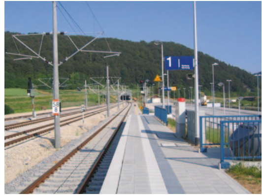
Abb. 15.14 Beleuchtungsanlage einer oberirdischen Personenverkehrsanlage
