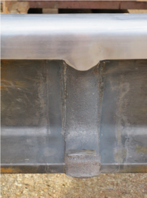
Abb. 3.14 Aluminothermische Schweißung. (Quelle: Archiv Alfred Wöhnhart)
