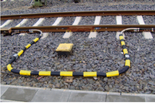
Abb. 17.44 Kabelverlegung im Schienenfuß
