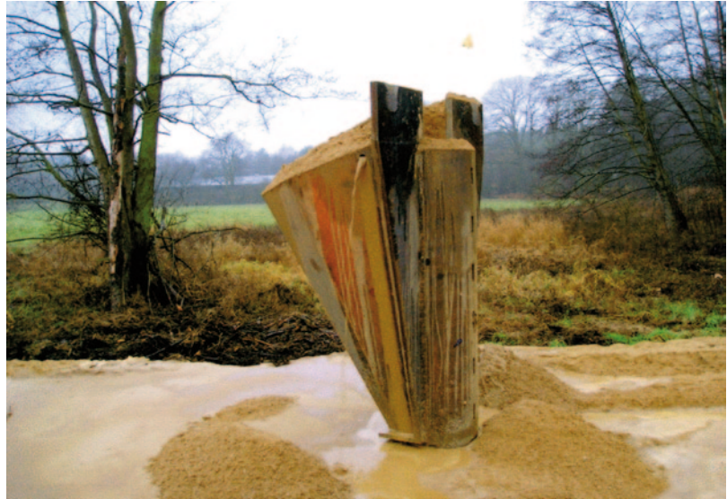
Abb. 4.68 Austritt gespannten Wassers ca. 3 m über Geländehöhe bei einem gerade hergestellten Sanddrain
