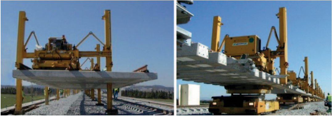
Abb. 5.63 Weichenmontage mit UWG bzw. PEM/LEM
