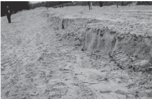
Abb. 4.73 Abriss einer Teilfläche der Arbeits- und Filterschicht-Maßnahme. Ruhezeit und danach Überschüttung gegen die Gleitlinie
