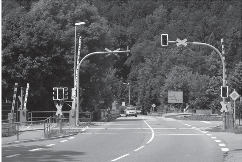
Abb. 13.15 Bahnübergang mit Halbschranken und Fußwegschranken
