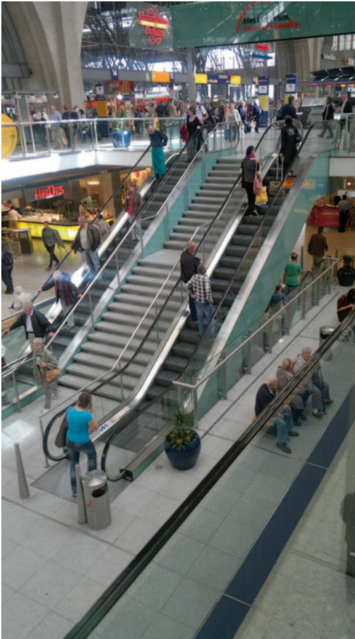
Abb. 15.18 Fahrtrepppe in einem Bahnhof, 3AC 230/400 V 50 Hz, ca. 2–5 kVA
