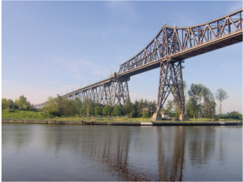
Abb. 7.6 Hochbrücke Rendsburg über den Nord-Ostsee-Kanal
