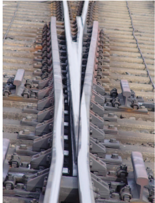
Abb. 5.41 Federnd bewegliche Herzstückspitze (rechts) mit Schrägstoß (Ausziehstoß) im Zweigggleis
