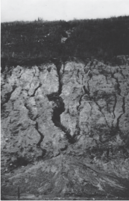
Abb. 4.33 Flächenhafte Erosion einer Rohböschung
