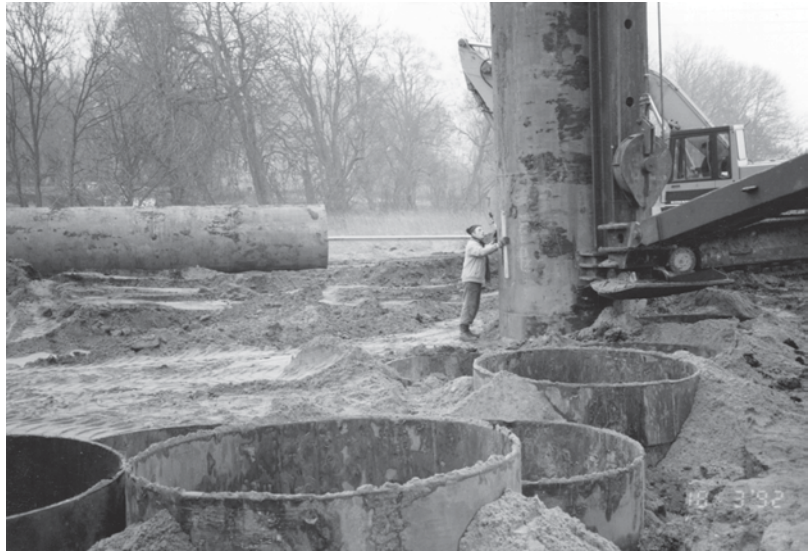
Abb. 4.95 Bodenaustausch mit Stahlrohren
