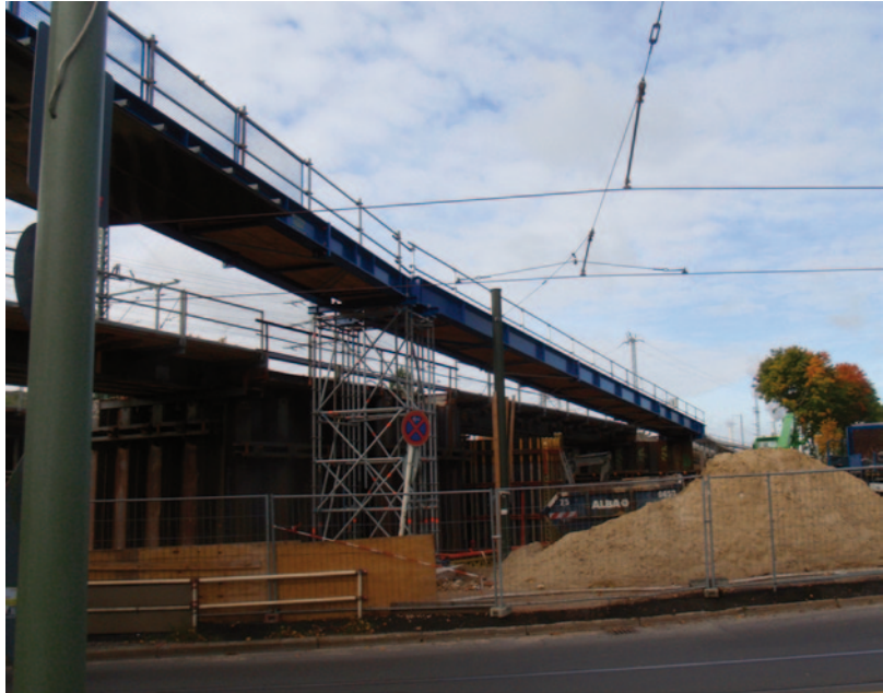
Abb. 16.19 Provisorische Kabelführung bei Brückeninstandsetzungen
