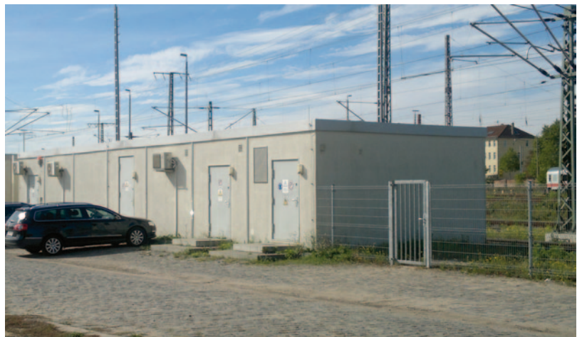
Abb. 15.12 Modulgebäude eines ESTW-A
