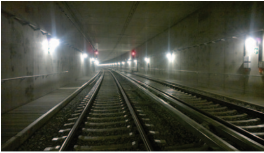
Abb. 15.9 Tunnel mit eingeschalteter TSB
