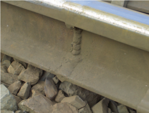
Abb. 3.15 Lichtbogen-Verbindungsschweißung. (Quelle: Alfred Wöhnhart)
