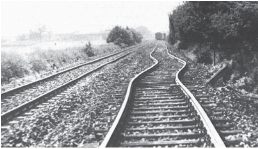
Abb. 2.21 Gleisverwerfung
