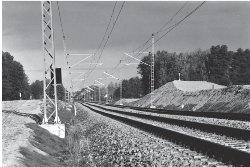
Abb. 4.105 Auflast­schüt­tung ent­sprechend der Moormäch­ti­g­keit – Gleis­ver­for­mun­gen ent­sprechen der Lage der Moorrinne
