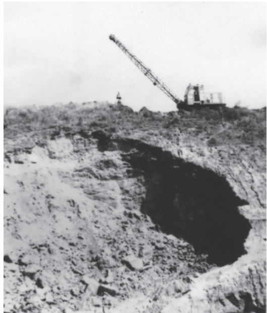
Abb. 4.36 Ausbluten einer mit Wasser gefüllten Sandlinse
