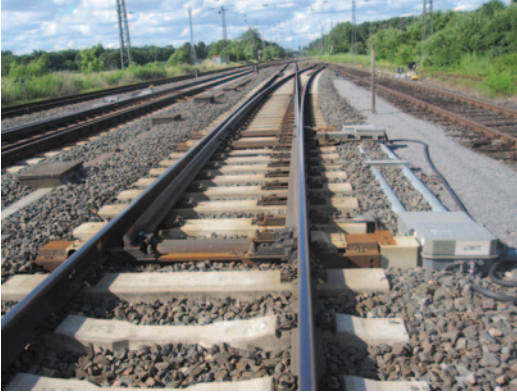
Abb. 5.53 Weiche mit Antrieb, Doppelstellgestänge und Verschlusschwellen
