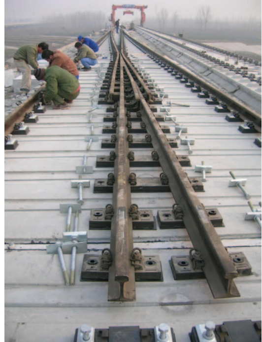
Abb. 5.72 Montiertes Herzstück
