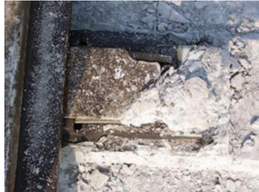
Abb. 5.68 Einbetonierte Gleitstuhplatte
