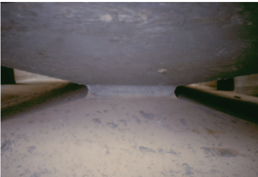
Abb. 7.10 Betongelenk
