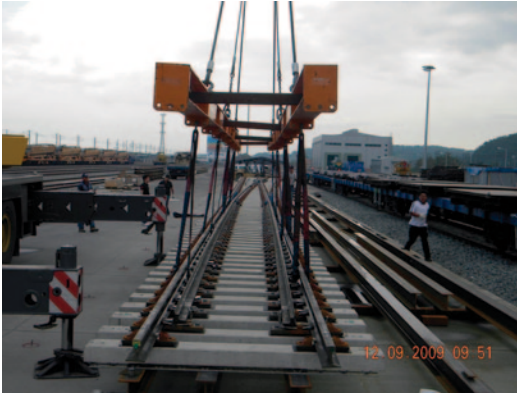
Abb. 5.66 Einsatz einer „Doppeltraverse“
