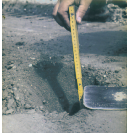
Abb. 4.22 Prüfung der Qualität der Durchmischung, Dicke der Schicht und Homogenität
