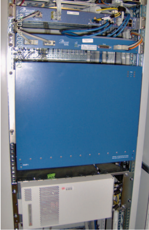
Abb. 17.42 19-Zoll-Schrank mit OMS 840, SDSL-Modem, XMP1 der Fa. Marconi und UMUX der Fa. ASCOM (von oben nach unten)
