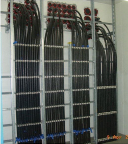
Abb. 16.1 Installation mit Kabelschellen auf Kabelleitern
