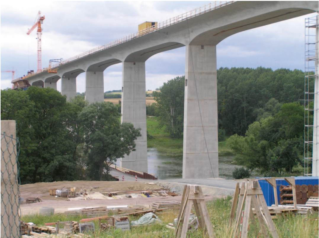
Abb. 7.13 Scherkondetalbrücke als semi-integrales Bauwerk
