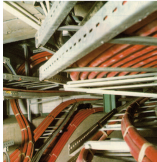
Abb. 16.2 Verlegung auf Kabelbahnen
