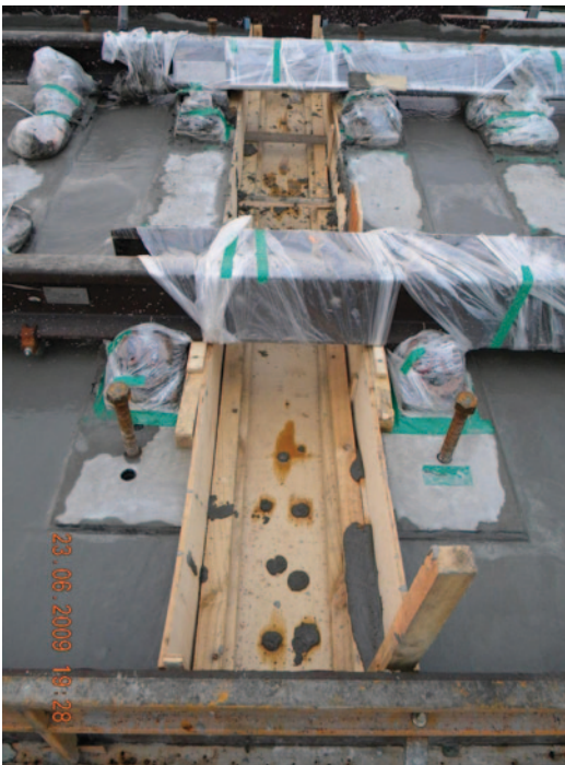
Abb. 5.67 Abschalung für Verschluss, Schutz der Fahrbahn vor Verunreinigung
