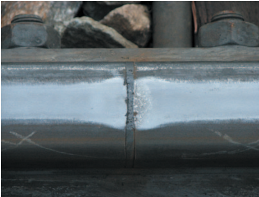
Abb. 10.13 Isolierstoß, Draufsicht
