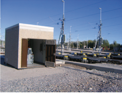
Abb. 15.20 Balkengleisbremse, hydraulisch, mit Hydraulikstation, 100 kVA, 3 AC 400 V 50 Hz
