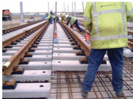
Abb. 5.65 Einbau einer vorsegmentierten Weiche mit geteilter Langschwelle
