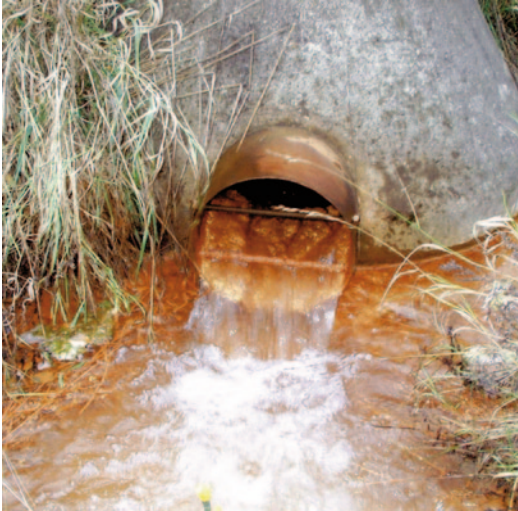
Abb. 4.63 Auslauf der noch klaren (eisenhaltigen) Wässer der unteren Ebene des Entwässerungssystems. Eintritt der Verockerung durch Luftsauerstoffkontakt erst im offenen Gewässer
