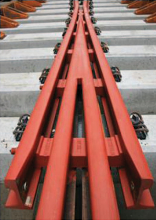
Abb. 5.37 Starres einfaches Herzstück mit Flügel­schienen (mit Noteinlauf) und Futter­stücken
