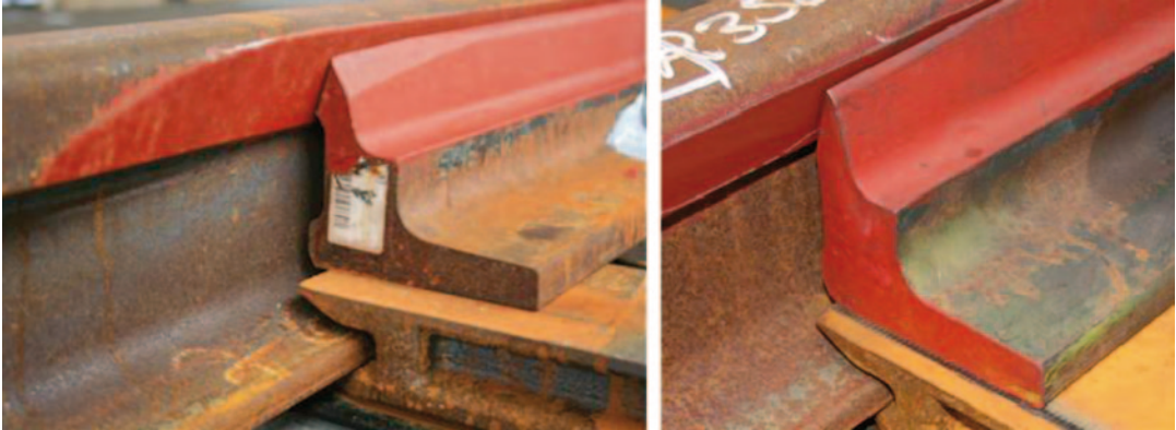
Abb. 5.35 Unterschnidung der Backenschiene für WITEC. Links starke Unterschnidung, rechts „normale“ Unterschnidung
