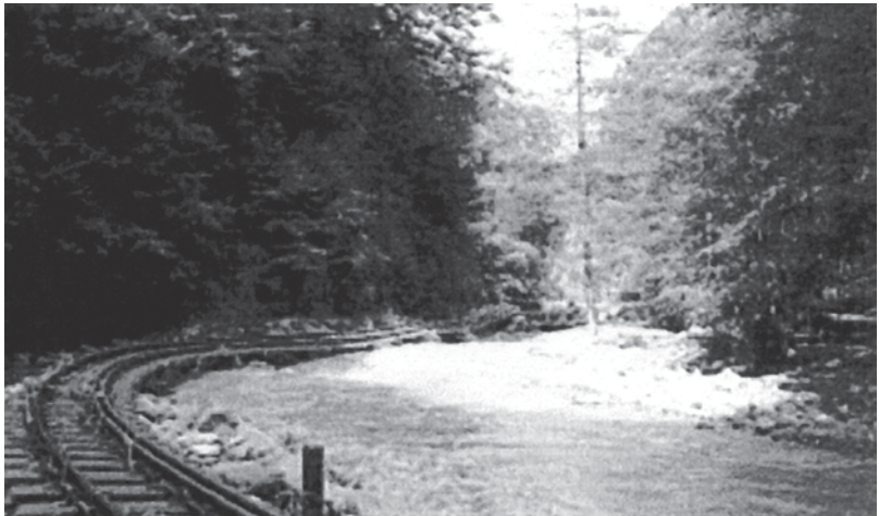
Abb. 4.53 Unterspülungen der Bahnanlagen im Rabenauer Grund. (2002 bei Dresden/Sachsen) (2)
