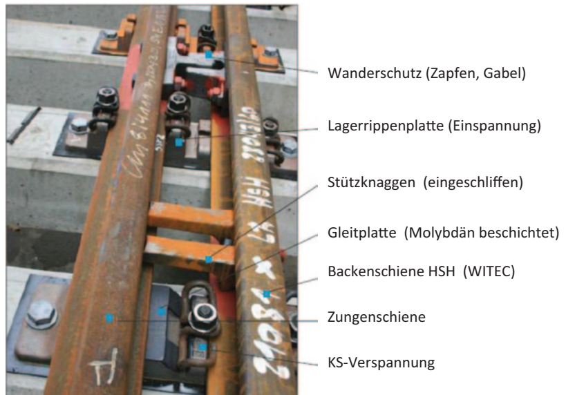
Abb. 5.27 Endbereich der Zunge (links) mit Stütznaggen und zweiteiligem Wanderschutz
