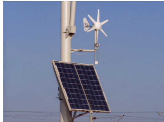
Abb. 15.30 Nutzung von Solar- und Windenergie bei der Verkehrsüberwachung
