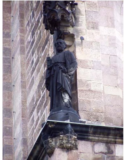
Bild 4: Teil des aus Zeisigwalder Porphyrtuff gebauten Turmes der Schloßkirche mit Sandsteinplastik und Sandsteingesims
