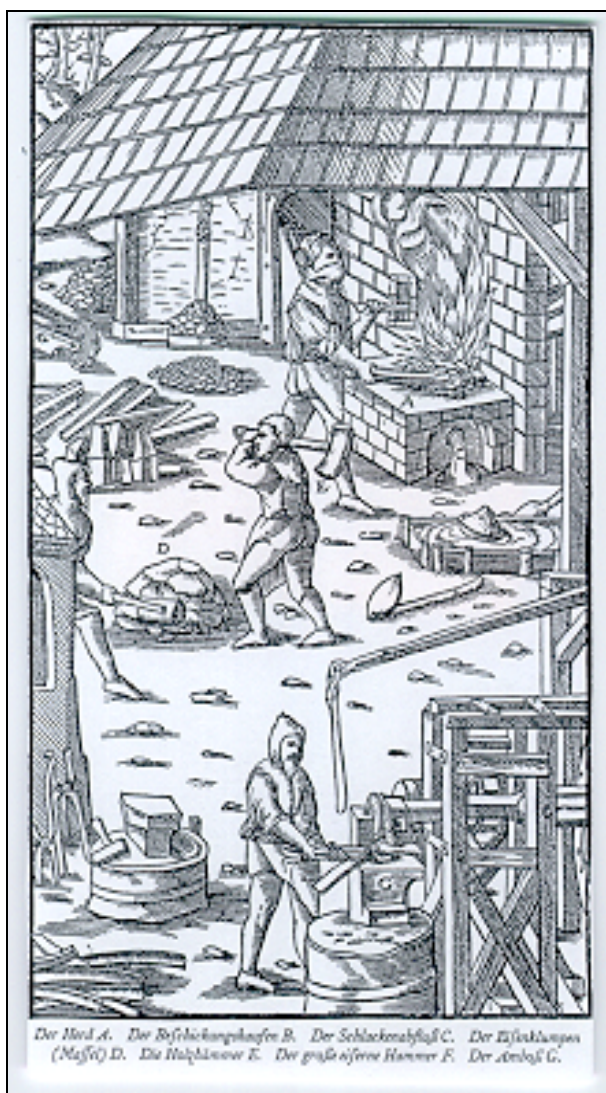
Abb. 3 - Hammerhüttenbetrieb mit Zerrenwerk/Rennwerk mit Rauchabzug, 1. Hälfte 16. Jahrhundert,
