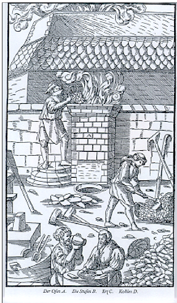
Abb. 9 - Hammerhütte mit Rennwerk-Stückofen mit Rauchabzug, 1. Hälfte 16. Jahrhundert, In: Agricola, G. (1556): De re metallica libri XII. Basel.
