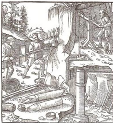
Die Saule A. Die Welle B. Der Schwengel, der sich um die Achse dreht C. Die Kolbenstange D. Der Griff E. Der Ring, durch den die beiden Rohre verbunden werden F.
