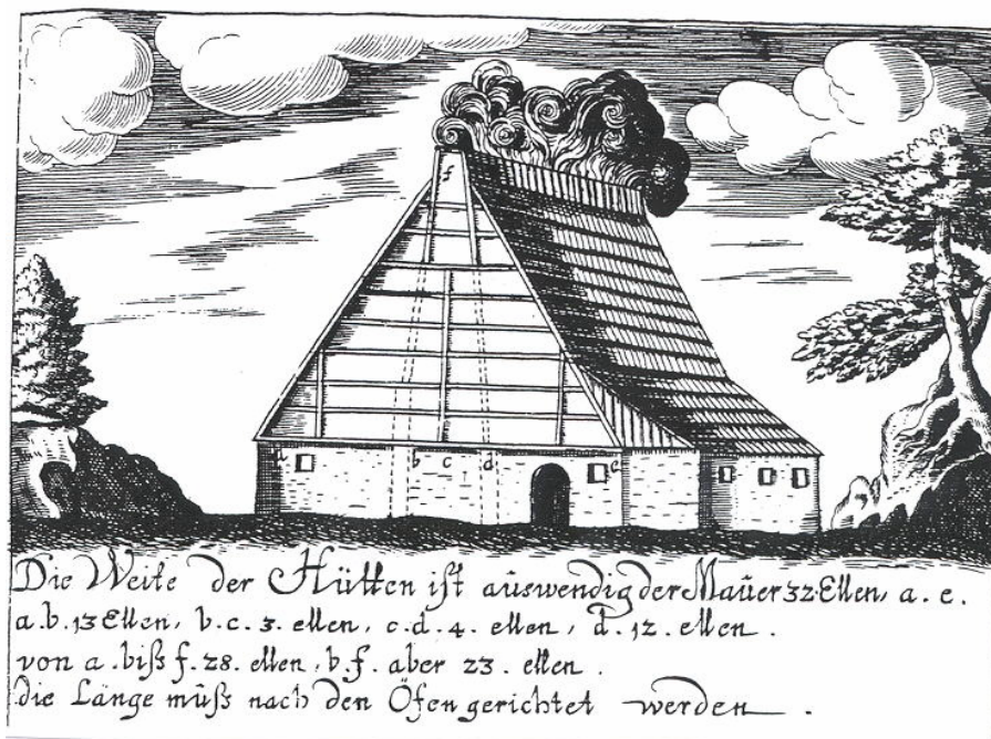
Abb. 3 Frühneuzeitliche Schmelzhütte nach BALTHASAR RÖBLER
