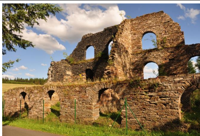
Heute noch vorhandene Reste des Kohlenvorrathshauses
