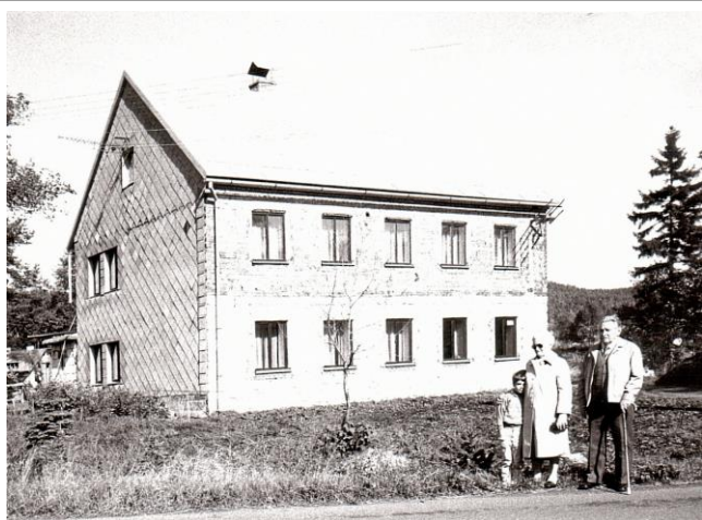
Die ehemalige Schule in den Achtzigerjahren
