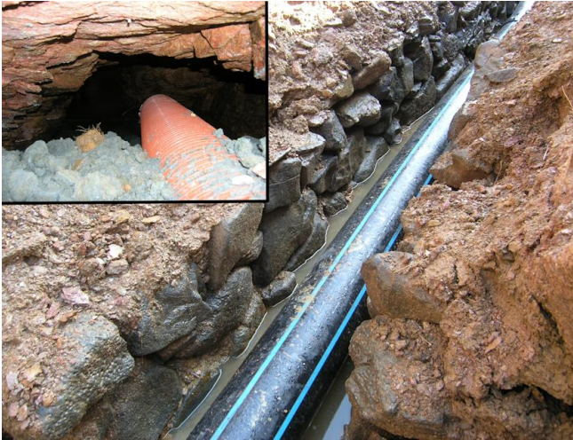
Mit Basaltsteinen ausgelegte Grabensohle in seinem Anfangsabschnitt auf dem Flurstück Nr. 1791, in welchem heutzutage die Wasserleitung verlegt ist, die bis in den alten Stolln führt. (Foto M. Urban aus der Zeit der Stärkung der Wasserleitung im Hengstererben im Jahr 2012).
