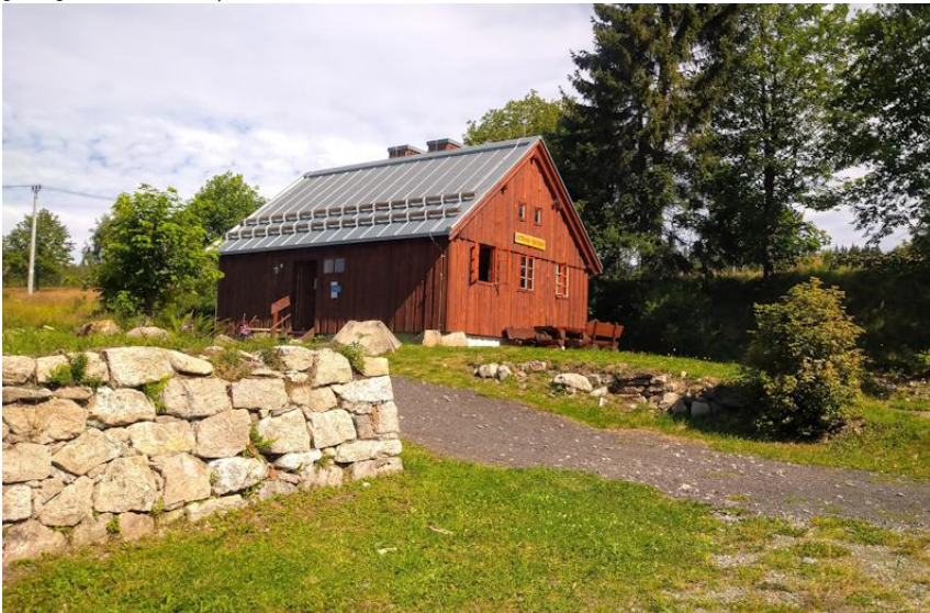
Seit dem Jahr 2015 steht über dem Schacht eine hölzerne Kaue, von der eine Stahltreppe bis auf die Sohle des Besucherstollns Christoph führt. Das Eingangsgebäude steht auf 4 Betonfundamenten des Förderturmes aus der Zeit des Zweiten Weltkrieges. Vor ihm findet man weitere zwei Betonfüße der Stützen. Die Steinwand im Vordergrund stammt aus der Zeit des Entstehens des ursprünglichen Schachtgebäudes (Foto: M. Urban).
