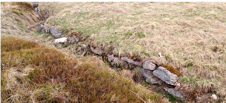
Alter Kunstgraben in der Nähe des Kiosks „Maringotka“. Die steinerne Ausmauerung ist teilweise bis heute gut sichtbar (Foto: M. Urban.).
