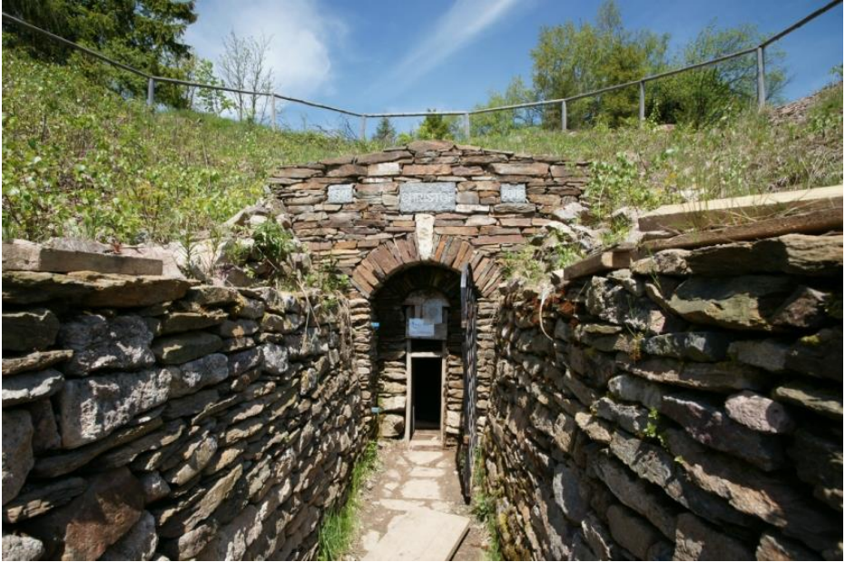
Gemauertes Portal des Stollns Christoph aus dem Jahr 2008 (Foto: J. Albrecht),
