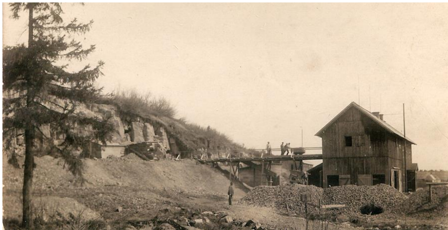
Betriebsgebäude im Steinbruch (Brecheranlage) um das Jahr 1930.
