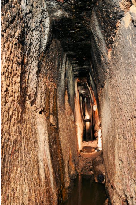
Mit Eisen und Schlägel aufgefahrener Stollnabschnitt des Christoph Stollns und die Große Kammer an seinem Ende vor der Öffnung für den Besucherverkehr (Foto: J. Albrecht).
