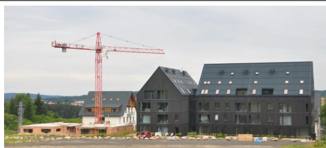
Bebauung im oberen Teil westlich an der Auffahrt zum Plešivec/Pleßberg
