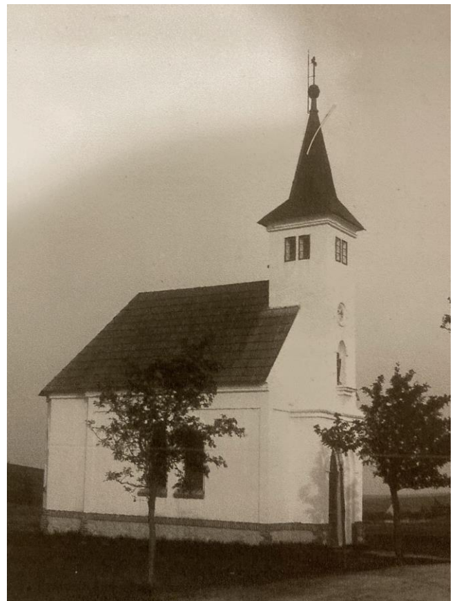
Die abgerissene Kapelle in Vorderzinnwald
