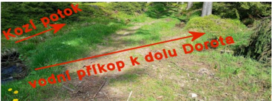
Die Stelle, an der ein Teil des Wassers des Ziegenbachs in einen künstlichen Wassergraben zur Dorothea-Zeche umgeleitet wird.
