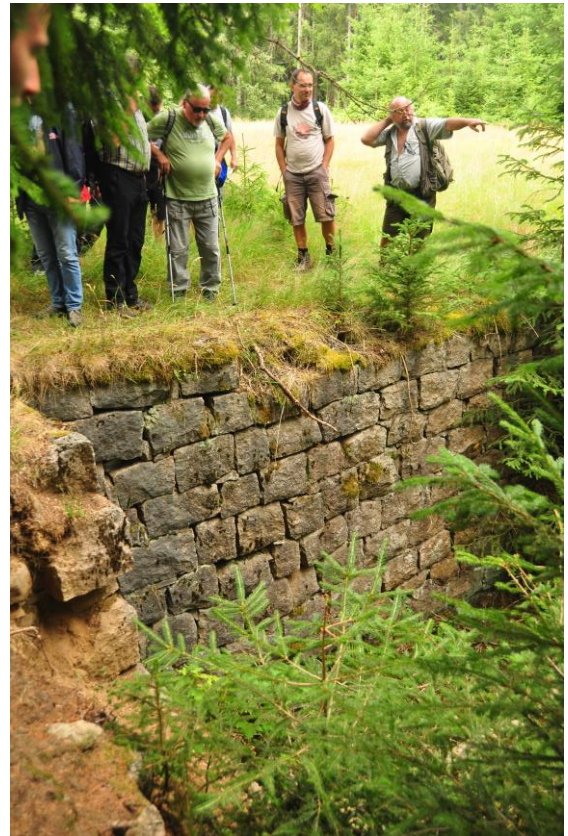
Steinmauer des einstigen Freibades in Brettmühl
