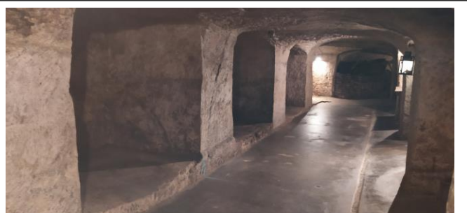
Die Kellerräume unter den Häusern am Markt.
