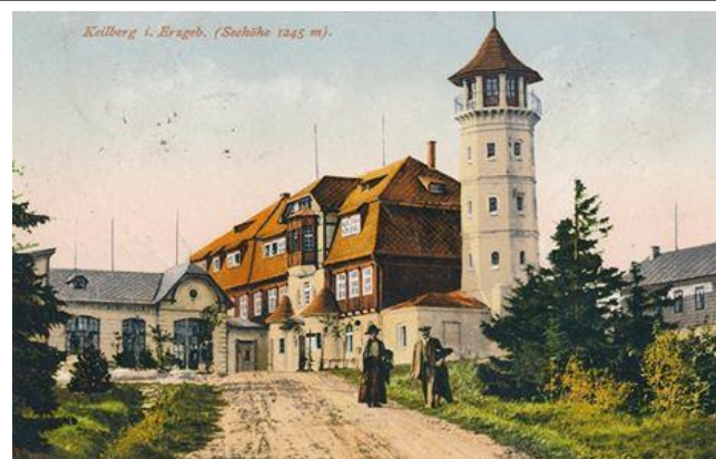
Das alte Unterkunftshaus wurde 1912-1913 komplett umgebaut
