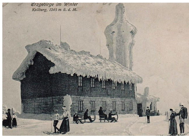
Turm mit aufgestocktem Unterkunftshaus
