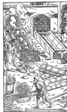
Abb. 1: Saigerherd nach Georgius Agricola „De re metallica“ (1556).
