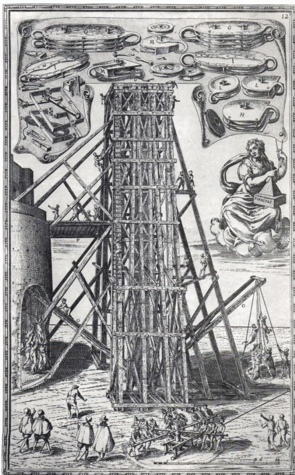
Abb. 2 Massierter Einsatz von Hebezeugen (Hebel, Göpelwinde, Flaschenzüge) bei dem technischen Großunternehmen der Umsetzung des Vatikanischen Obelisken auf dem Petersplatz in Rom unter der Leitung von Domenico Fontana im Jahr 1586.
